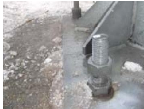
設置後1年程度の付属物のアンカーボルトのゆるみ (国土交通省H26)
