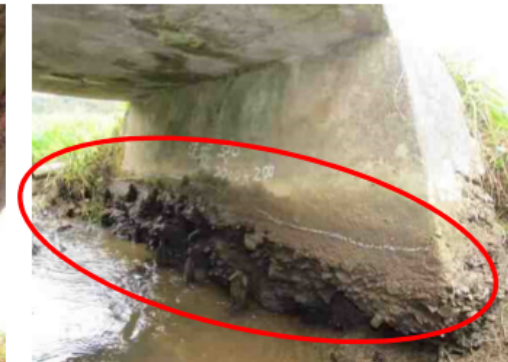
【京丹後市 溝落橋】
