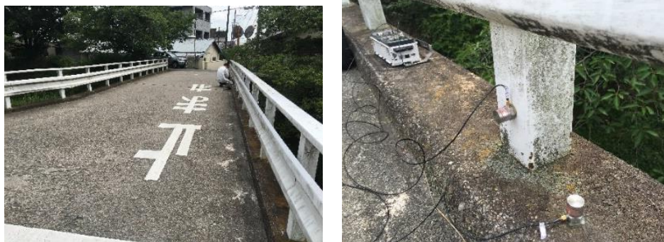
写真3-④-(1)-3.2 橋梁の外観およびセンサ設置状況（奥玉川橋）
