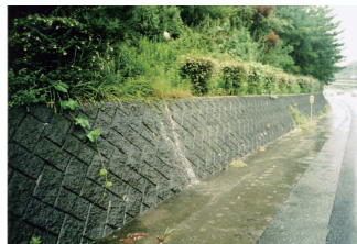
のり面保護工原地盤の沈下
