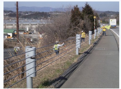
盛土のり面の目視点検
