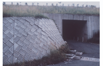
盛土のり面の崩落
