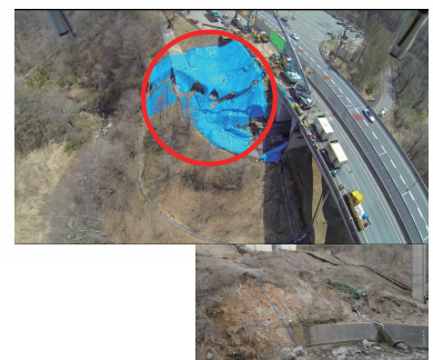
盛土のり面の崩落
