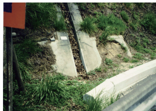
のり面保護工原地盤の沈下
