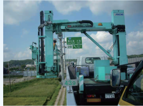
照明設備の構造検査
