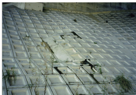
のり面保護工原地盤の沈下
