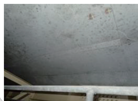
微細なひび割れは確認されるが、大きな損傷は外観上発見できなかった。
