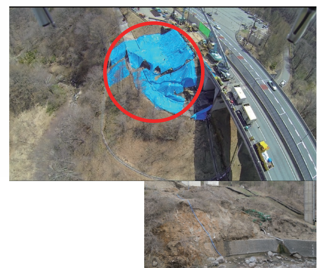
盛土のり面の崩落
