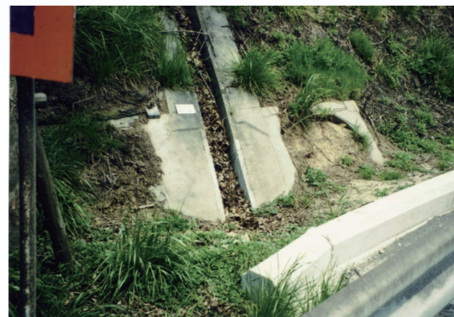
のり面保護工原地盤の沈下
