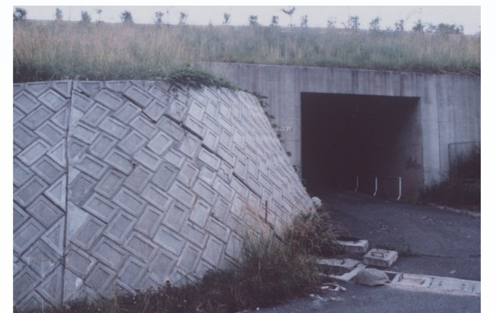
盛土のり面の崩落
