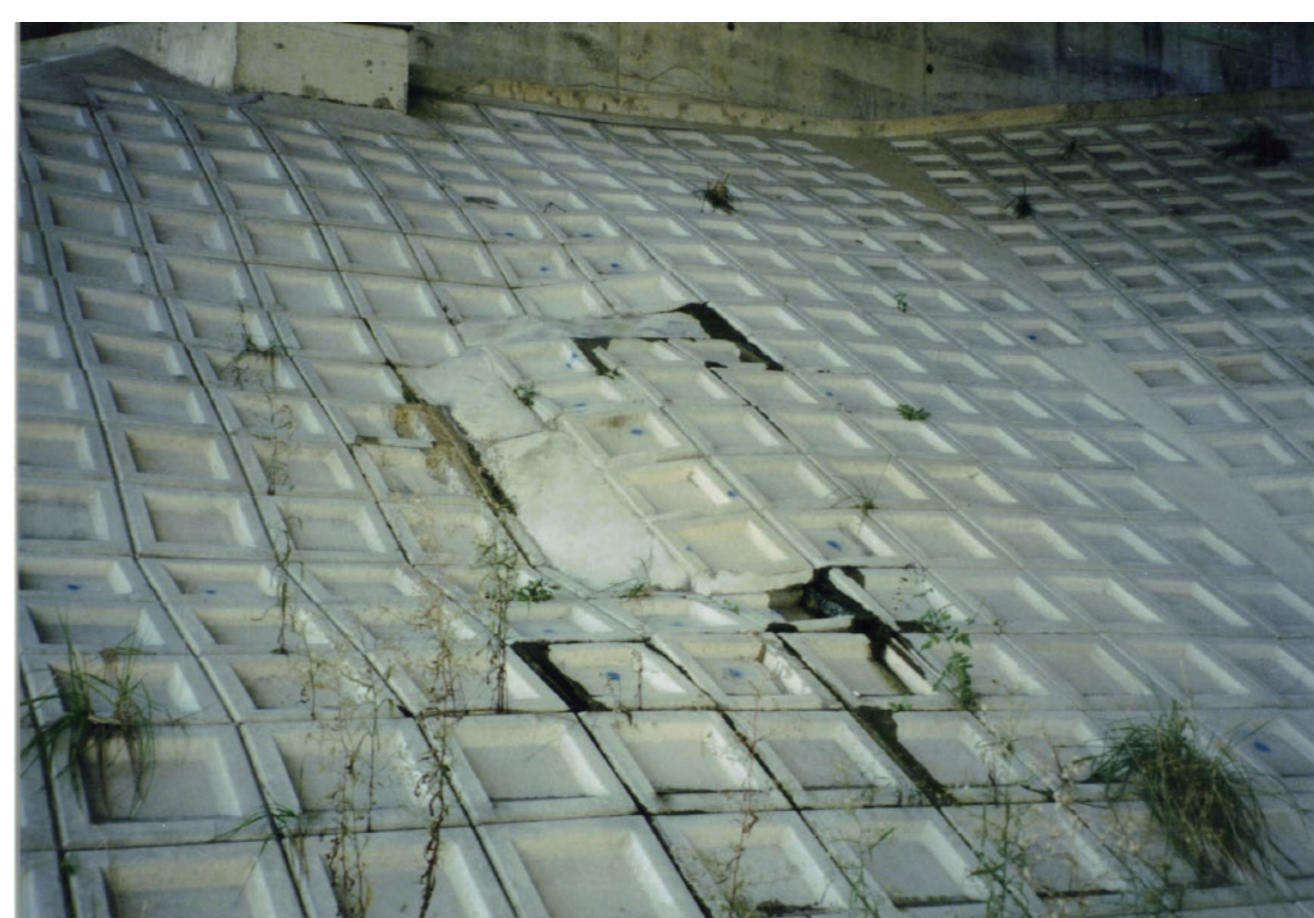
のり面保護工原地盤の沈下
