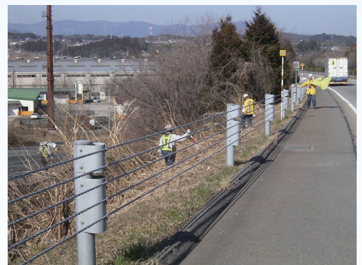
盛土のり面の目視点検
