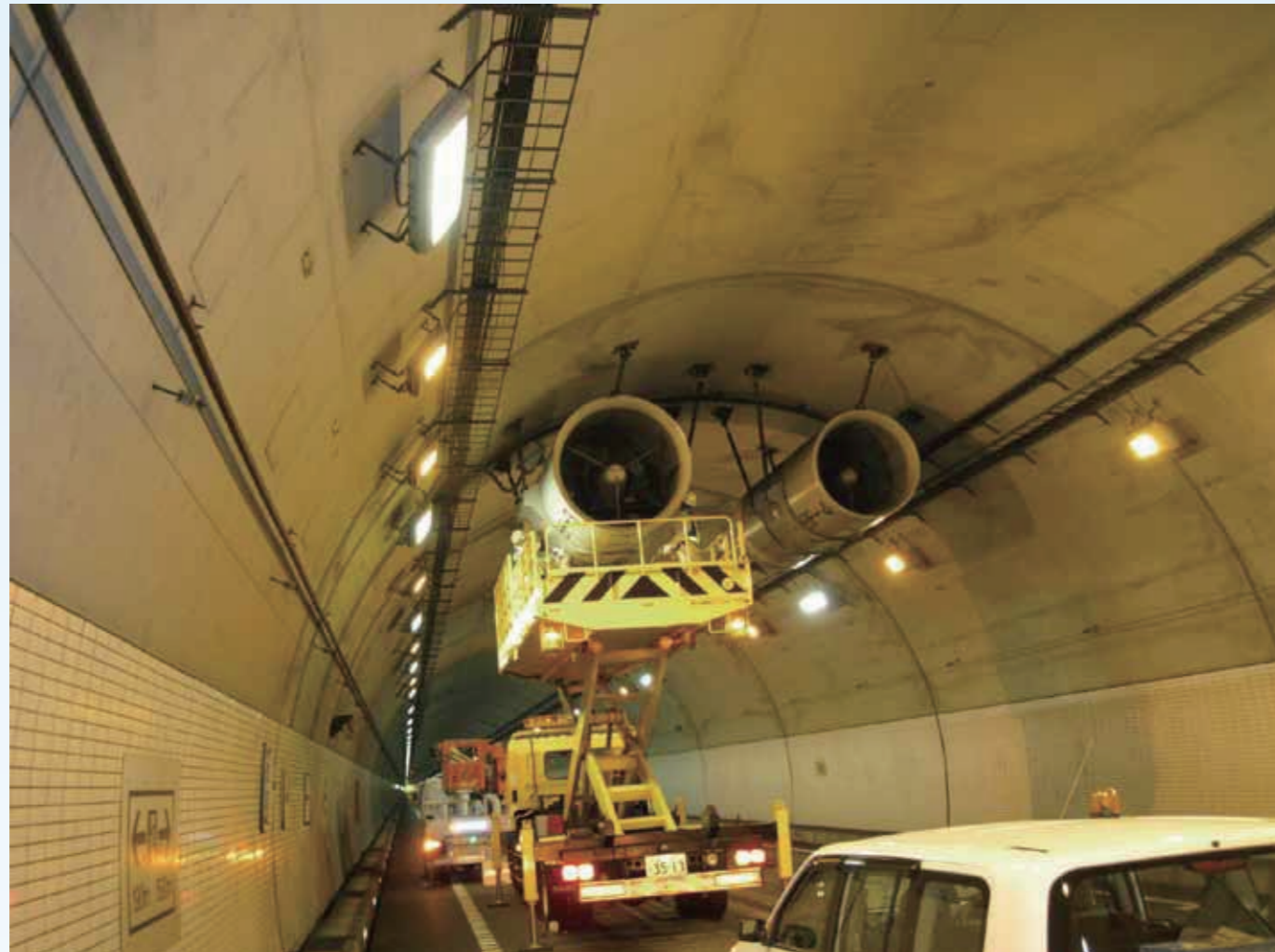
トンネル換気設備の構造検査
