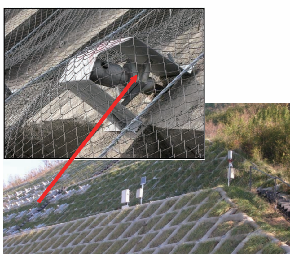
切土のり面の グラウンドアンカーの突出
