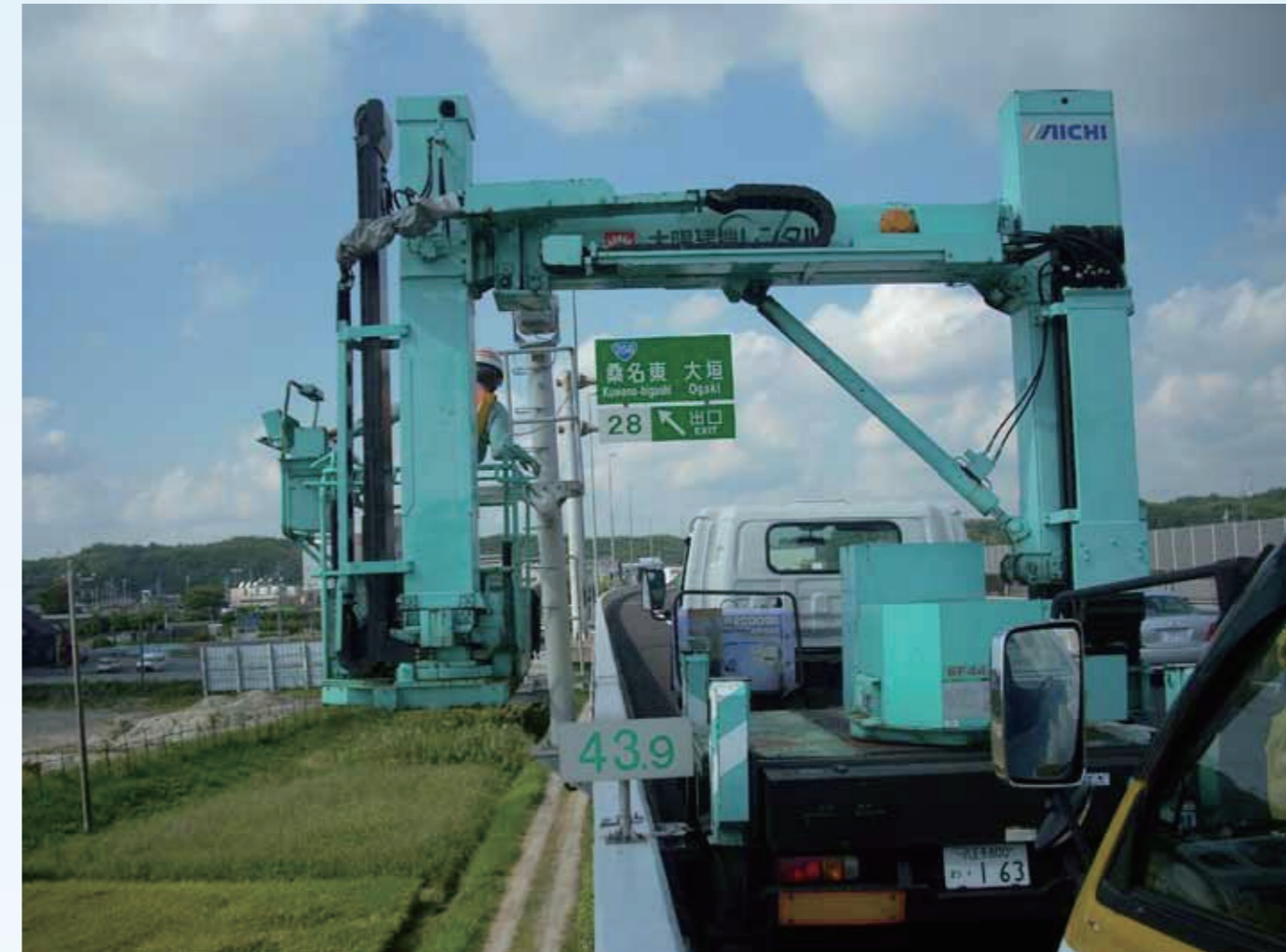
照明設備の構造検査
