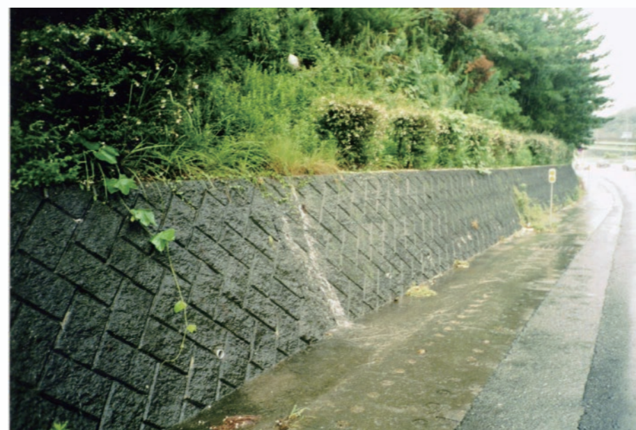
のり面保護工原地盤の沈下
