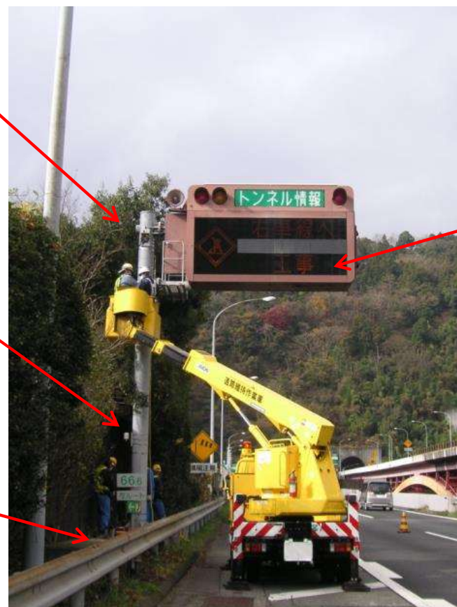
情報板全景 (設置作業時)
