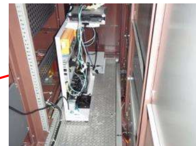
傾斜計、加速度計 PC,記録器他 (内部)
