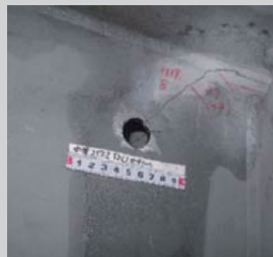
ストップホールによる補修
