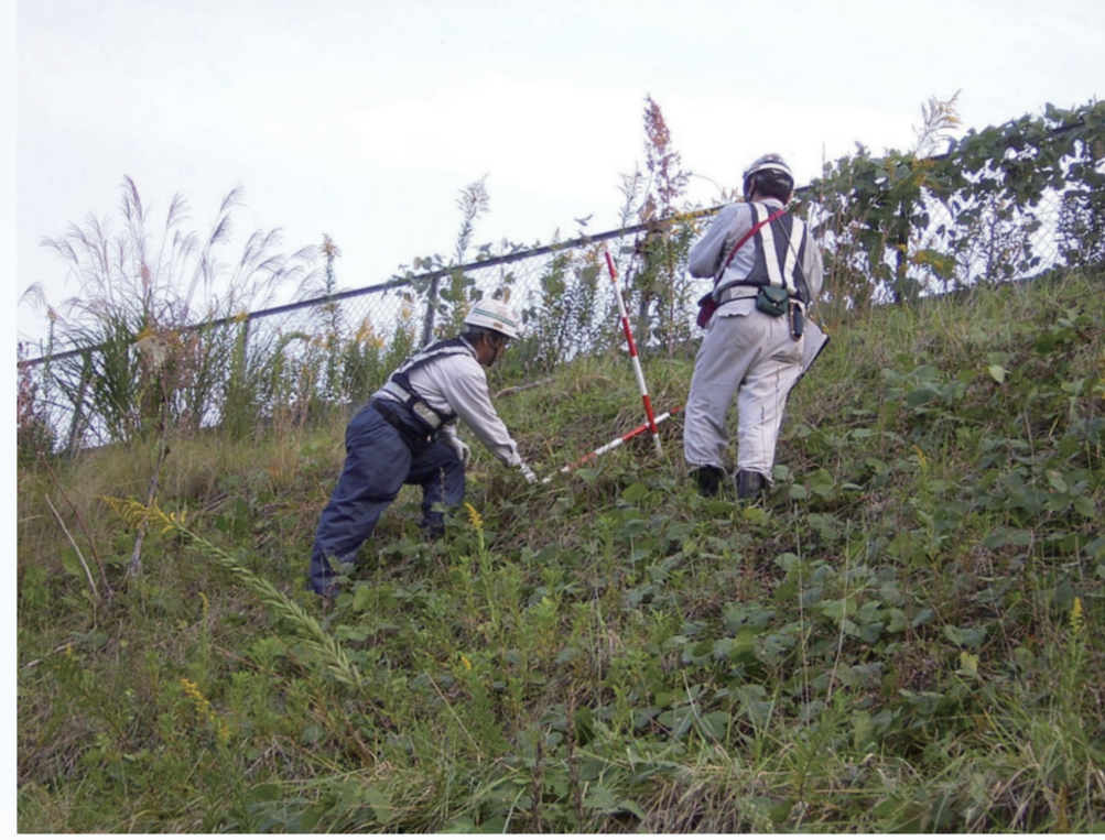
のり面勾配の調査
