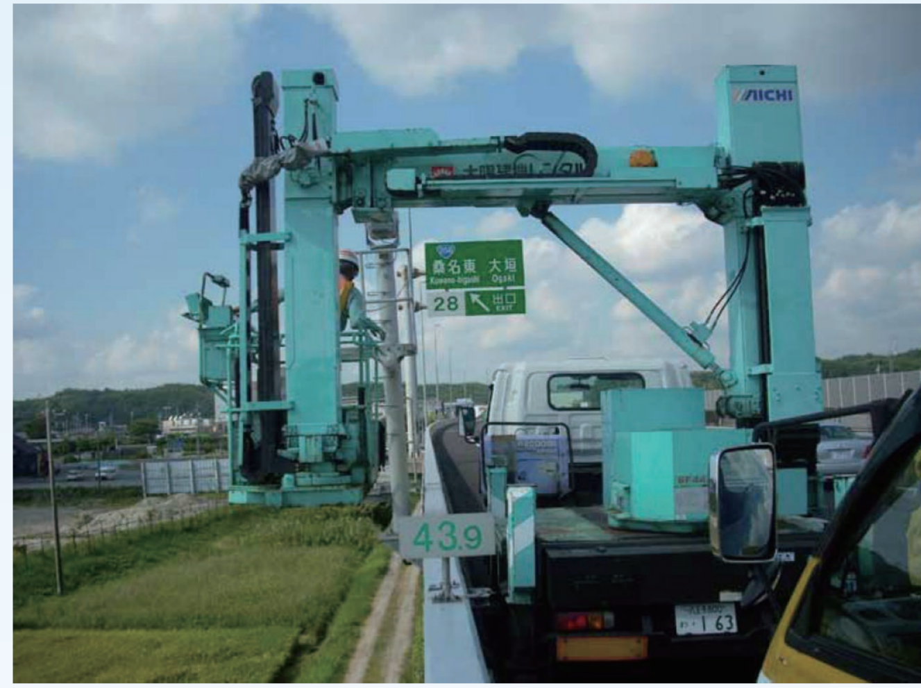
照明設備の構造検査
