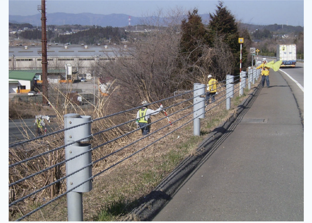
盛土のり面の目視点検
