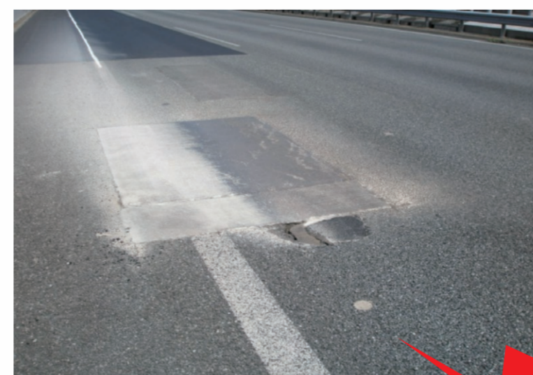
舗装の損傷
