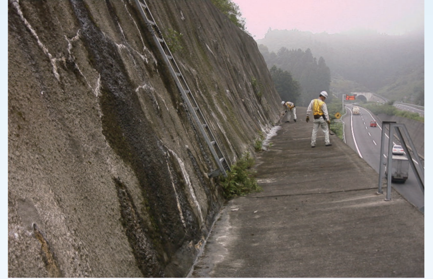
のり面小段部からの目視点検
