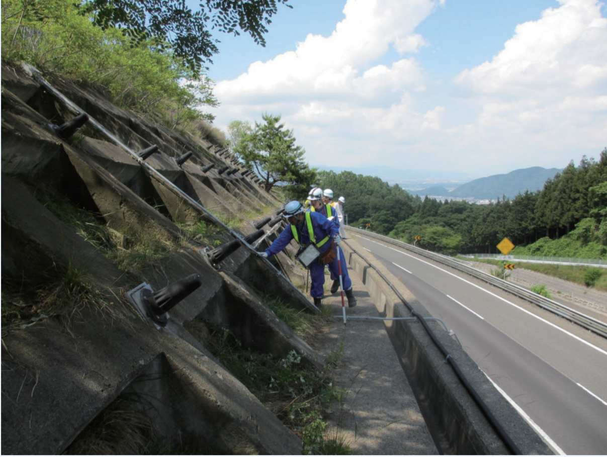
切土のり面のり枠、グラウンドアンカーの目視点検
