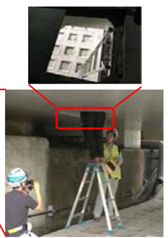
進入口 約70cm四方の開口。 大型計器は搬入不可。
