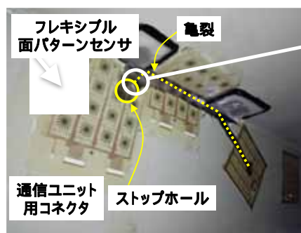
高速道路箱桁内におけるフレキシブル面パターンセンサの実証試験
