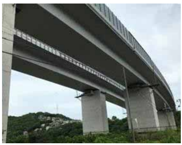
候補高速道路橋梁 PC 橋梁(箱桁) 橋長: 372.3m
