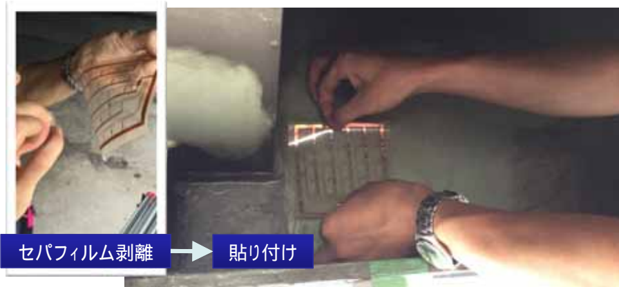
フレキシブル面パターンセンサの実橋への施工
