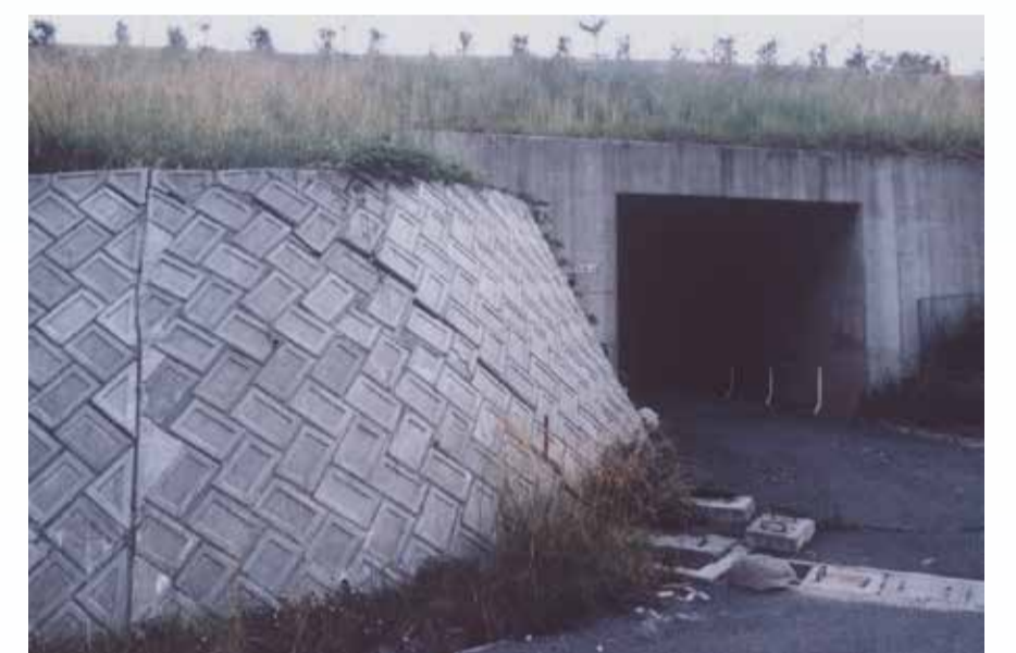
盛土のり面の崩落
