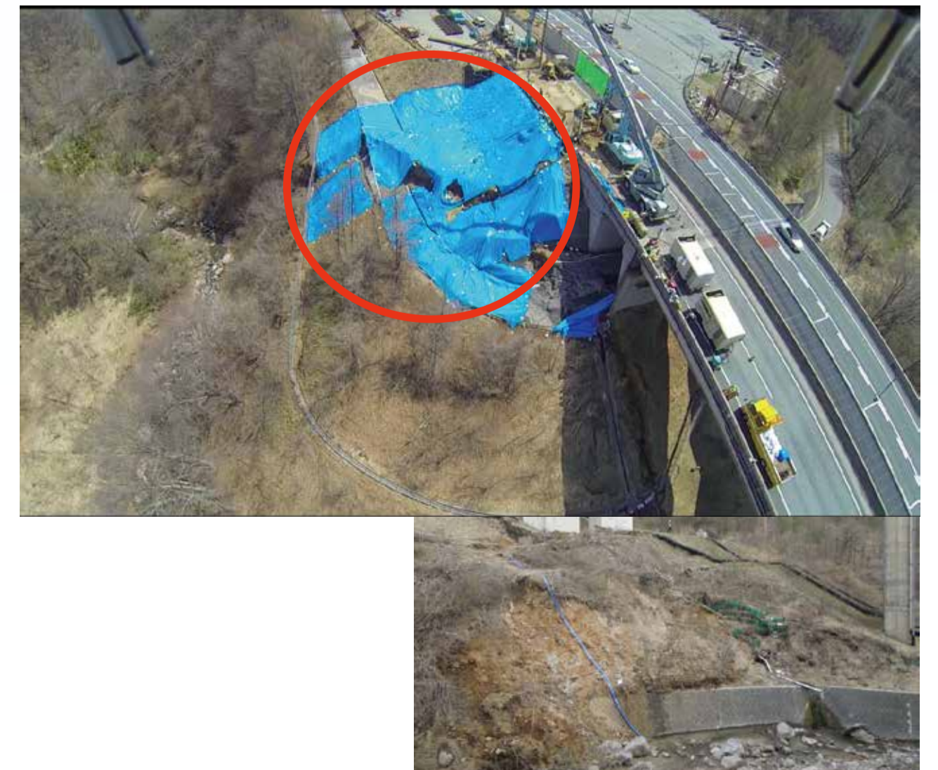
盛土のり面の崩落
