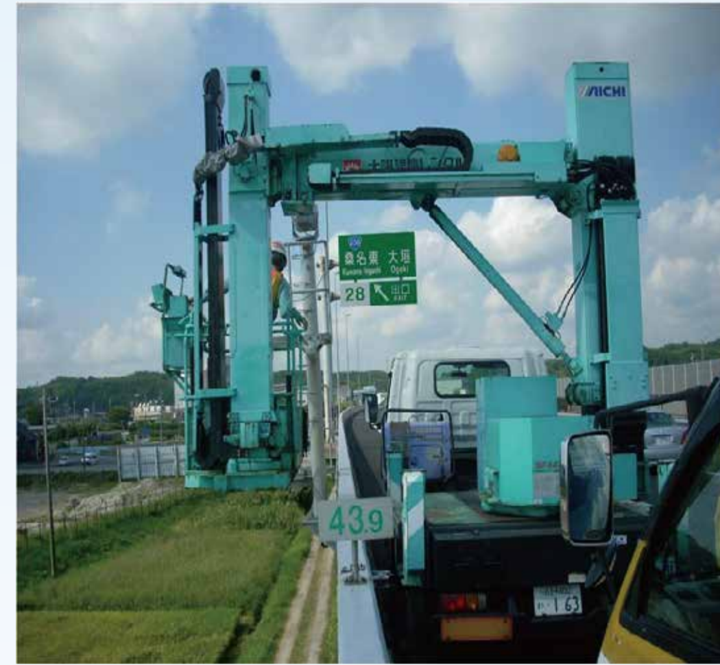
照明設備の構造検査
