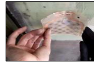
「貼るだけ」施工の様子
