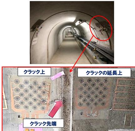
図 8 監査廊内の亀裂上に設置した面パターンセンサ
