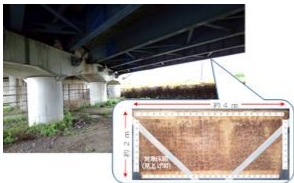
図6 橋梁外観と計測対象箇所
