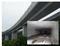
SAセンサが所望の帯域(**1Hz~1MHz**)で**有効な感度**を有することを確認した。また、SAセンサ端末を高速道路橋梁に設置し、**長期実証実験を完了**した。橋梁RC床版から得られたデータをもとに内部損傷を推定する解析を行ない、破壊試験により有効性を確認した。また、**雨滴による効率的な検知手法も考案**し、有効性検証を行なった。**PC鋼材破断システムをPC橋に設置**し実証実験を行ない、動作の**有効性は実大供試体で確認**した。
