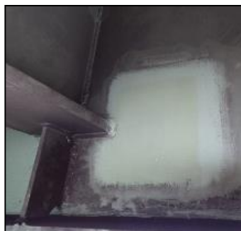
下地処理(プライマ塗布)
