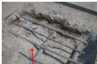
コンクリートの砂利化
