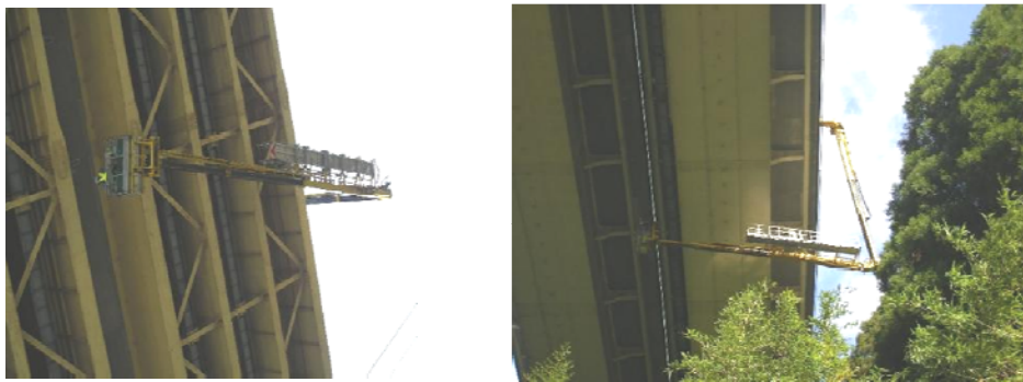
[ 中央分離帯側張出床版(閉塞) ] 高所作業車
