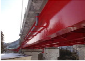
鋼桁の塗替塗装
