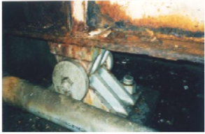
鋼桁の劣化
