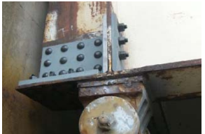
鋼桁の当て板補修
