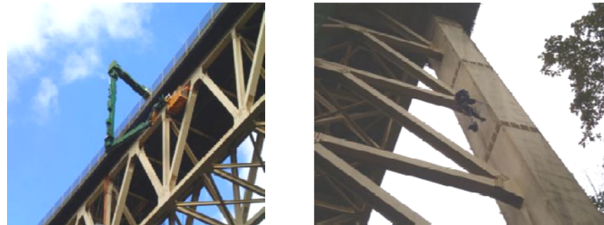
[トラス 斜材部材] 高所作業車
