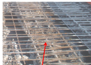
鉄筋の腐食
