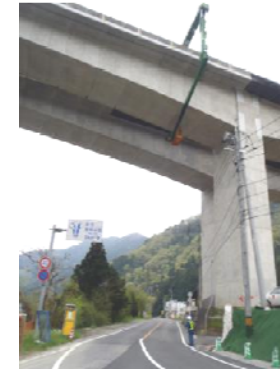
[中央分離帯側張出床版(閉塞)] 高所作業車
