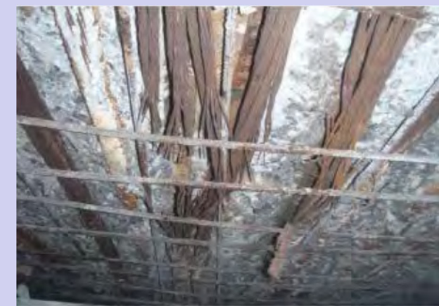
PC筋の破断
