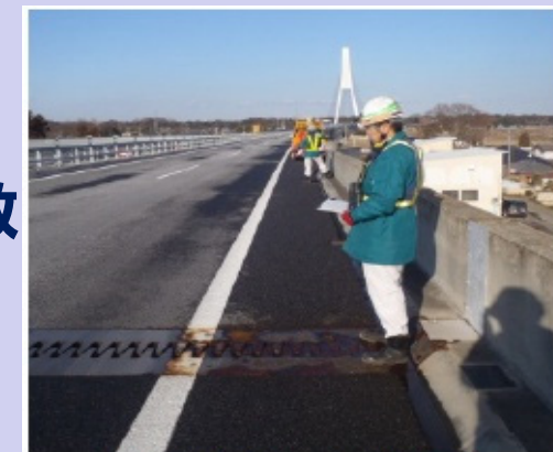
(土木点検) 日常点検
